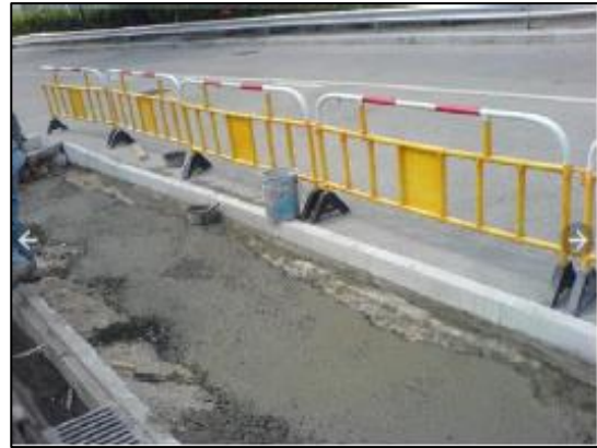
(d) Concrete paving
